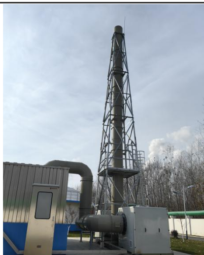
三期废气处理装置及排气筒（DA002）
