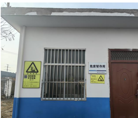
危废间外部标识牌
