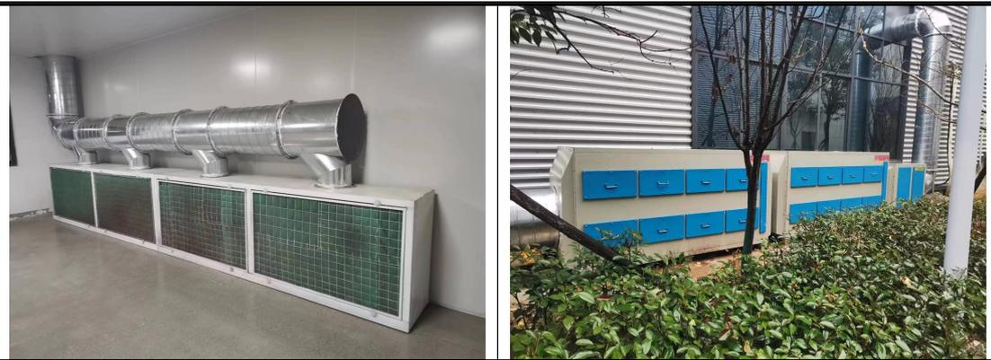
密闭喷漆房及过滤棉+二级活性炭废气处理装置
