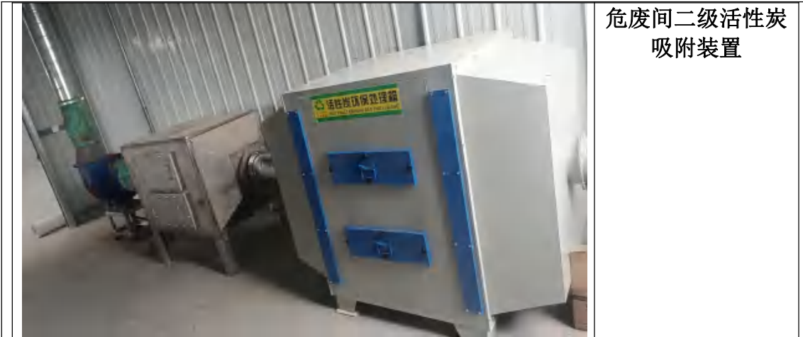
图 3.2-4 项目（一期）无组织废气处理工艺实图
