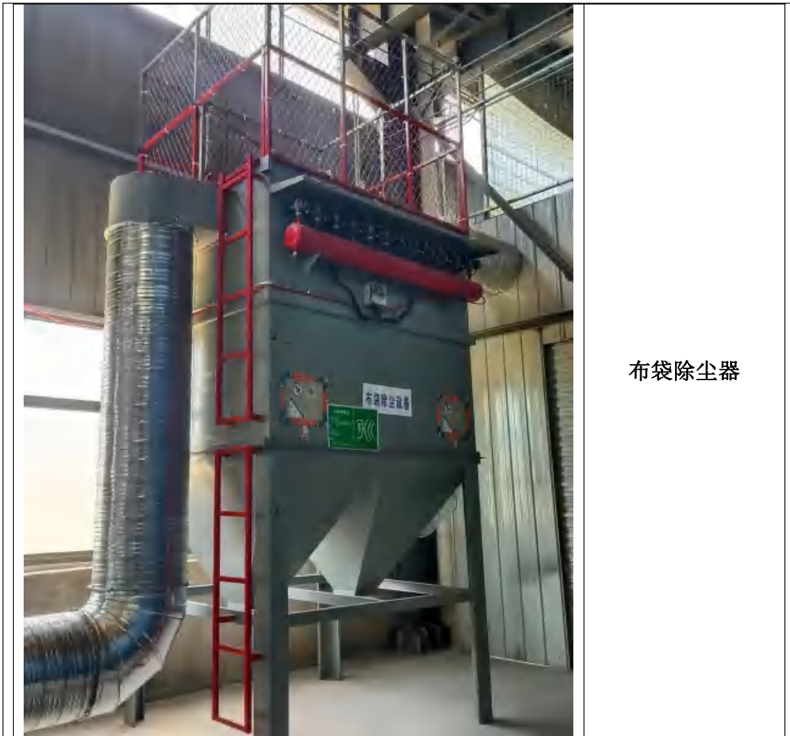
图 3.2-2 项目（一期）有组织废气处理工艺实图
