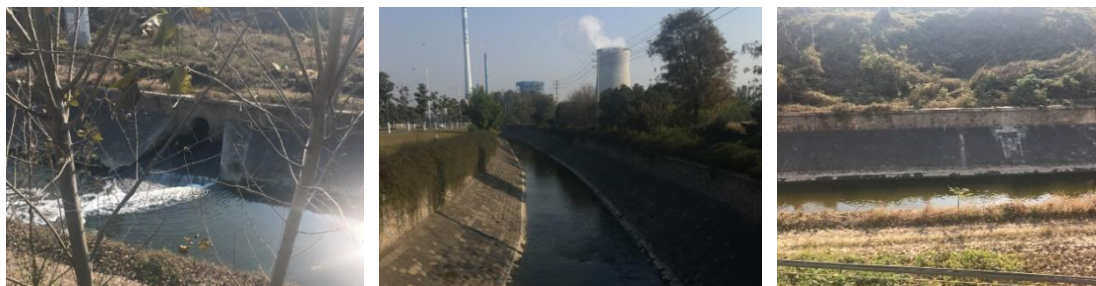
图 2.6-1 “尾水导流”工程徐州经济技术开发区段现状
