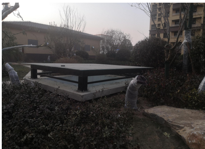
地下车库排放口
