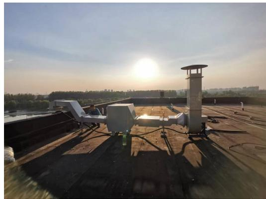
无机废气处理装置
