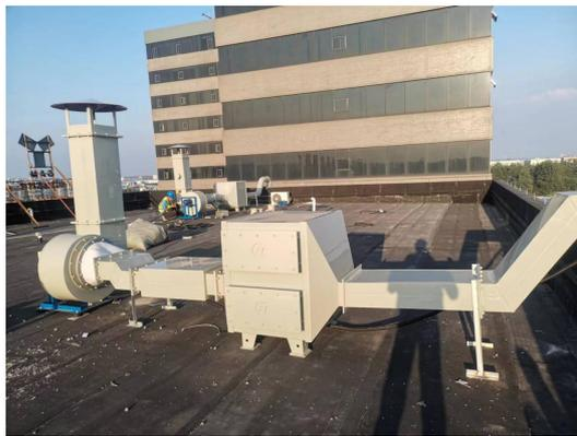
无机废气处理装置
