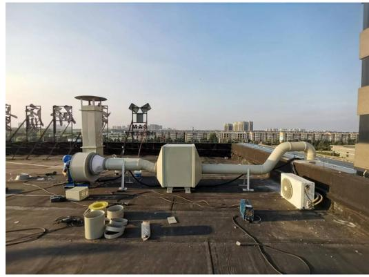
有机废气处理装置
