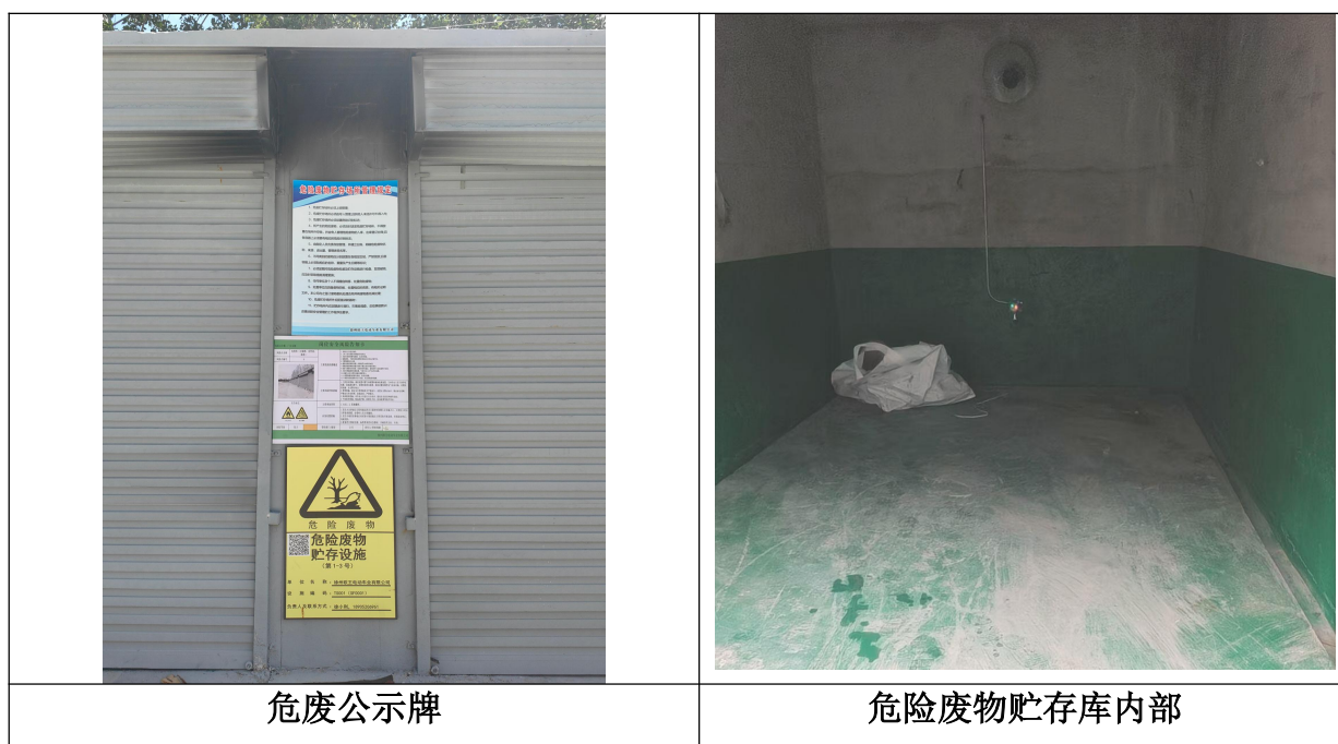
图 4.1-6 危废暂存间实拍图
