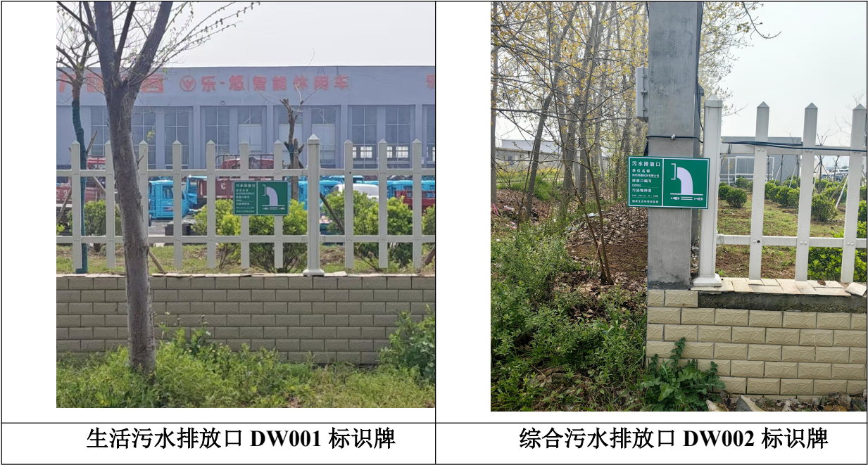
图 4.1-2 废水治理设施实拍图
