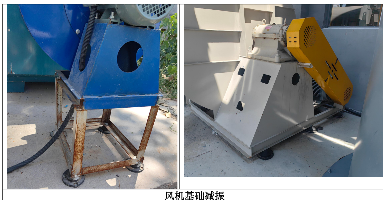
图 4.1-5 降噪措施实拍图
