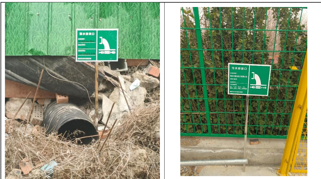
雨水排口及标识牌
