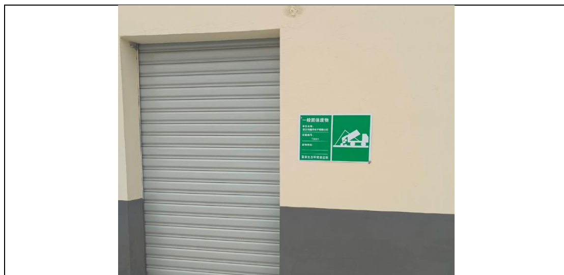
一般固废暂存间及相关标识牌设置情况
