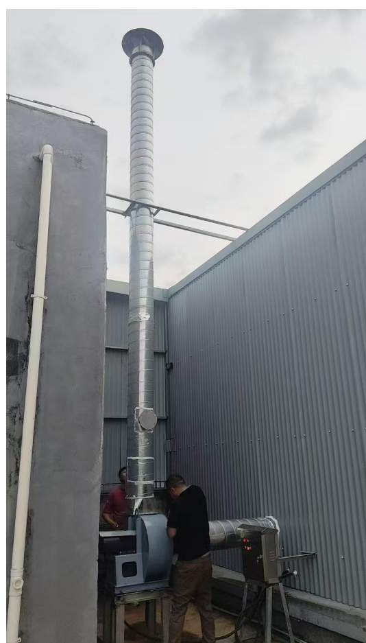
喷砂废气排气筒 DA006
