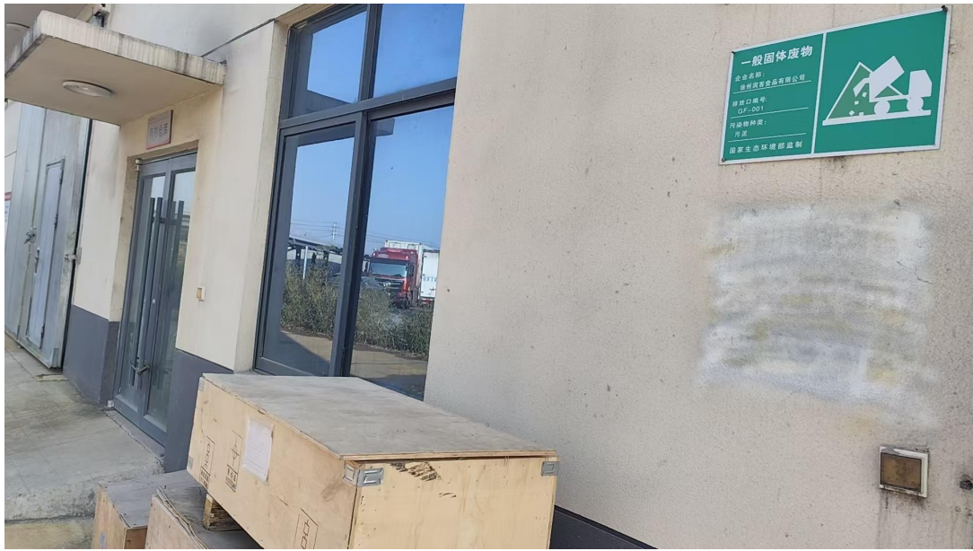
一般固废暂存场所
