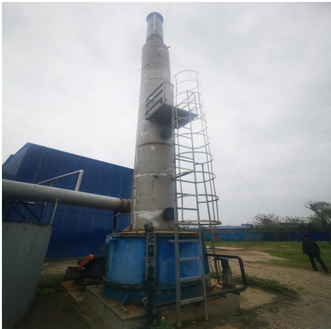
图 4.1-7 污水处理站废气排放口采样平台
