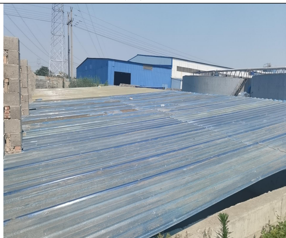
中间水池（加盖密闭）
