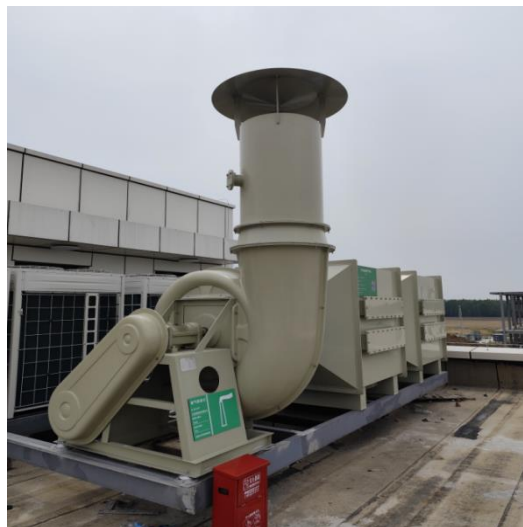
分析化验废气废气处理设置及排气筒 DA002
