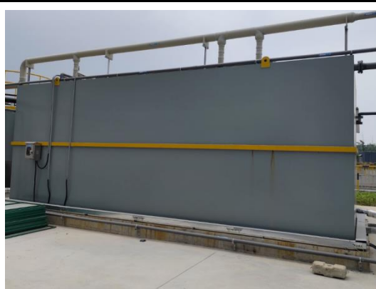
A/O 反应池、二沉池、清水池
