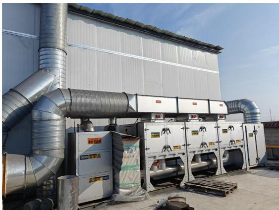
喷漆房废气处理装置
