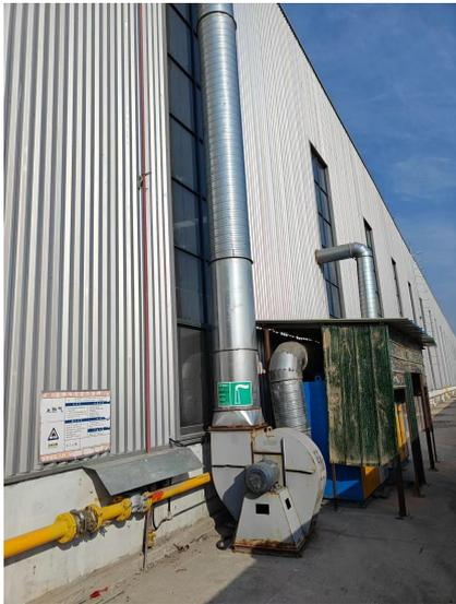
塑粉固化工序废气处理设施
