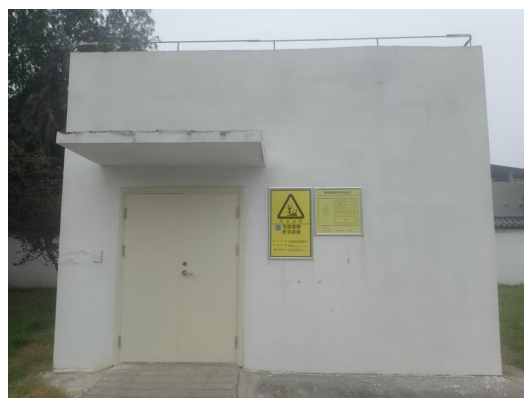
依托一期工程现有危废间
