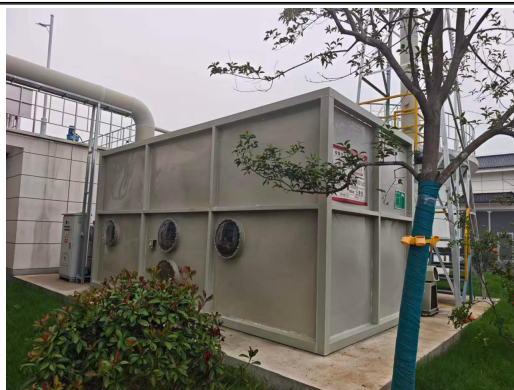
废气治理装置（生物除臭滤池）
