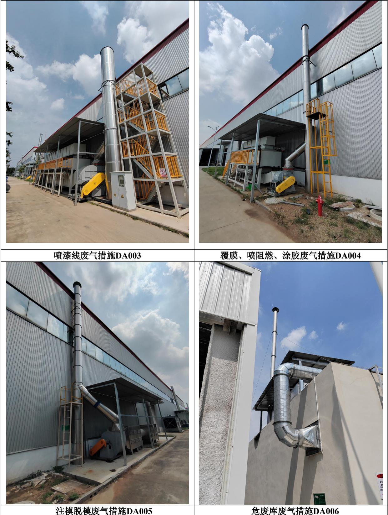
图 4.1-3 厂区废气处理设施图
