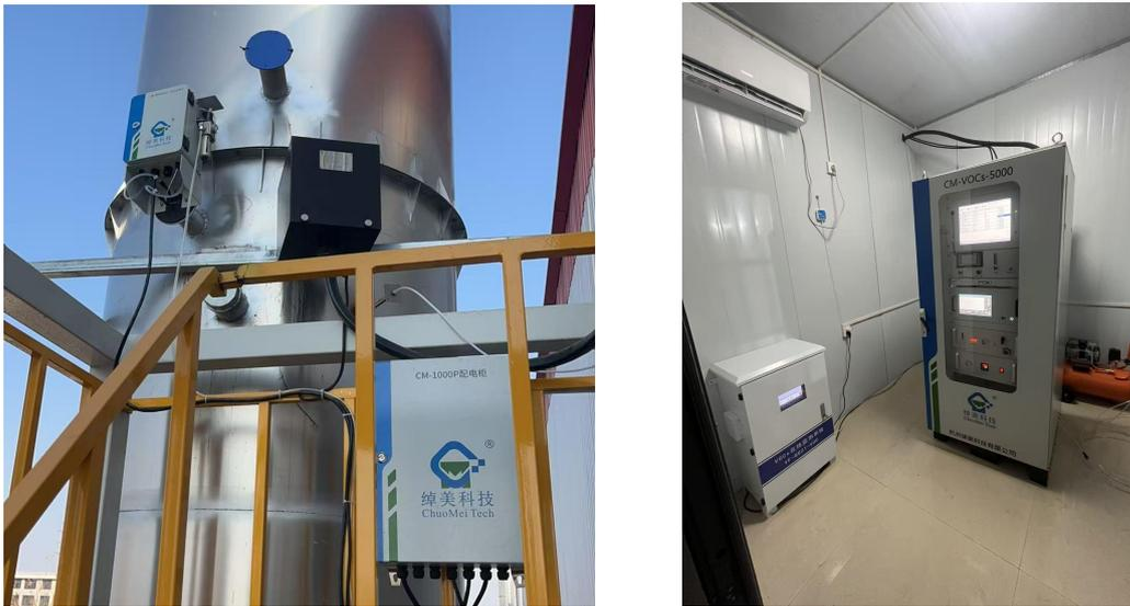
图 4.1-5 喷漆线废气排放口 (DA003) 在线监测设施
