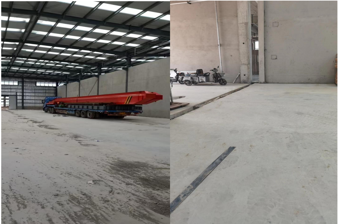
厂房内部地面现状图
